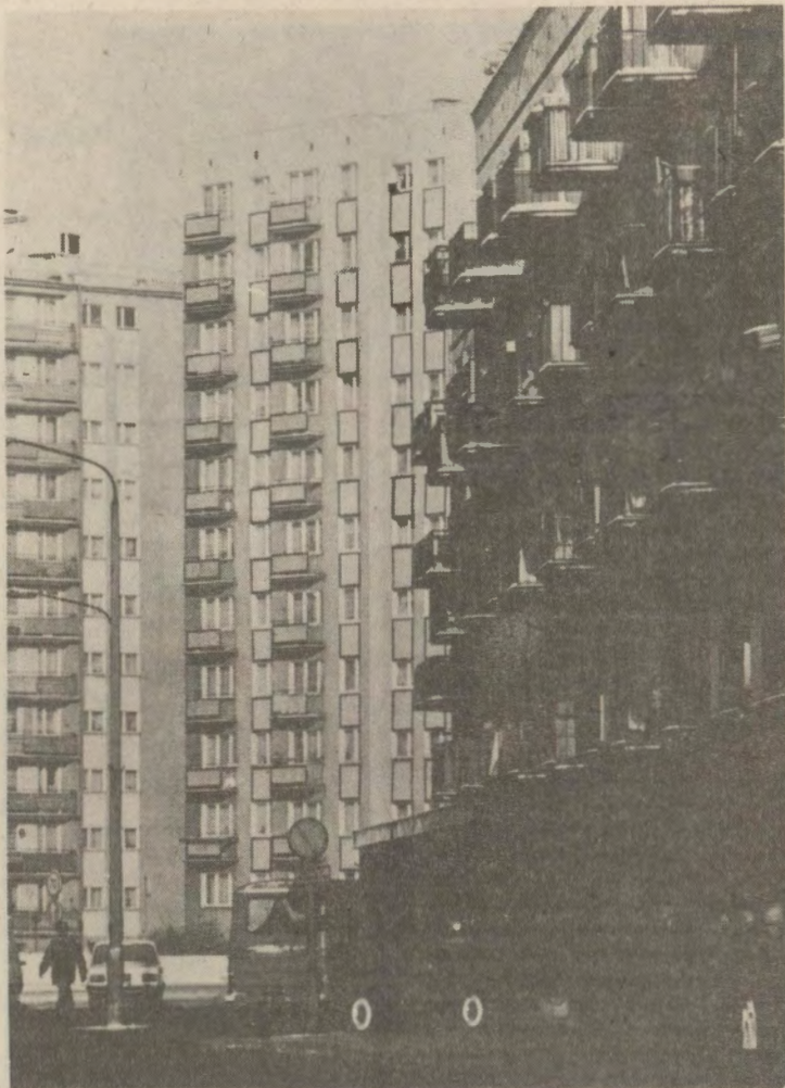
Większość mieszkańców Pili mieszka w nowoczesnych budynkach spółdzielczości mieszkaniowej. Foto: Stanisław Pręgowski
